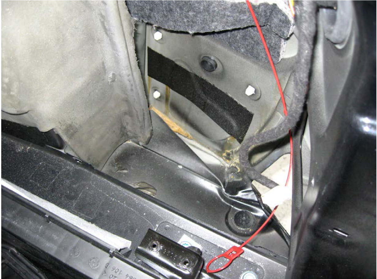
Deformierte Innenbleche (Bild Flückiger)
