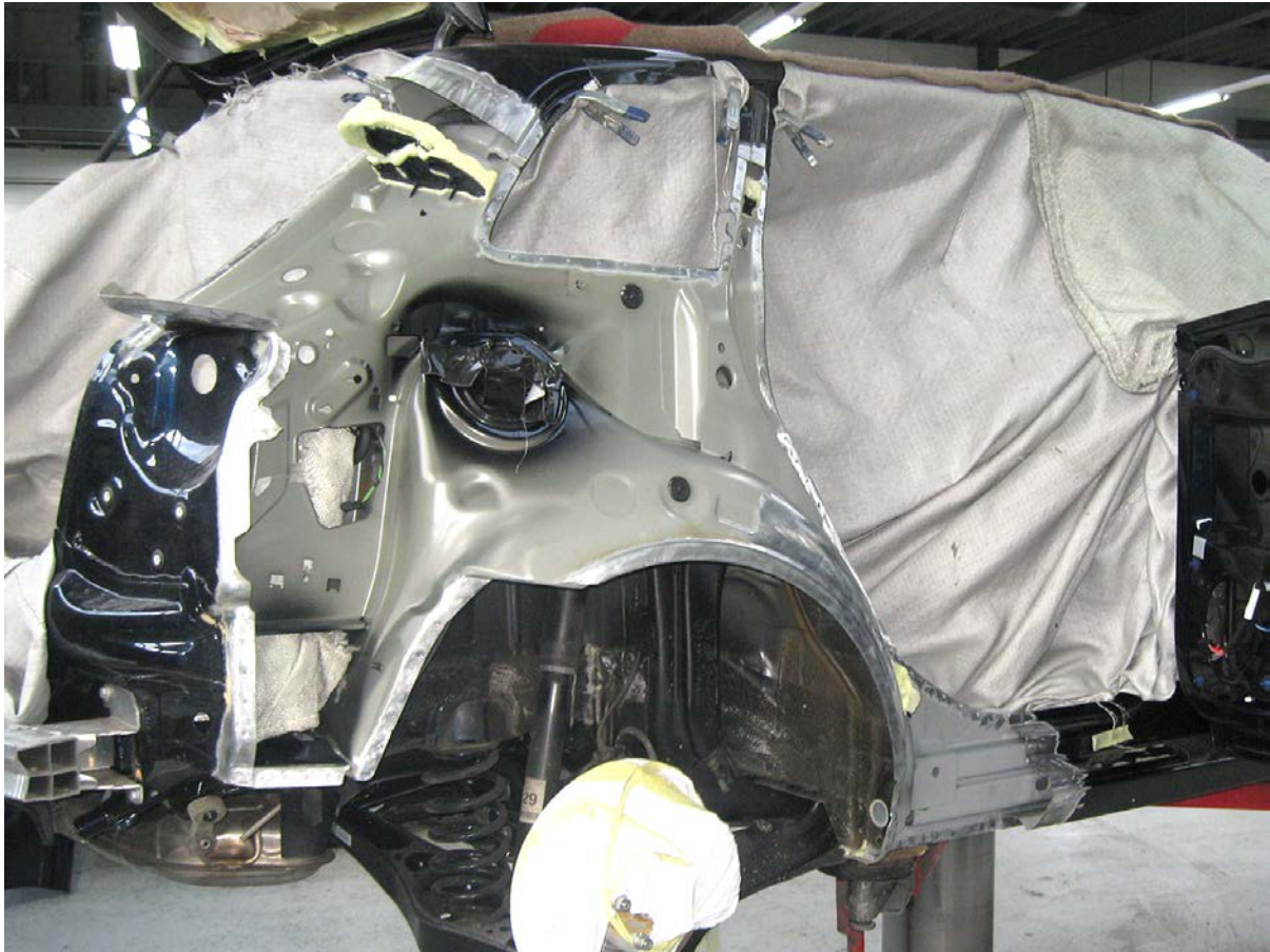
Bild: Ersatz an den vom Hersteller frei gegebenen Schnittstellen (Bild Flückiger)
